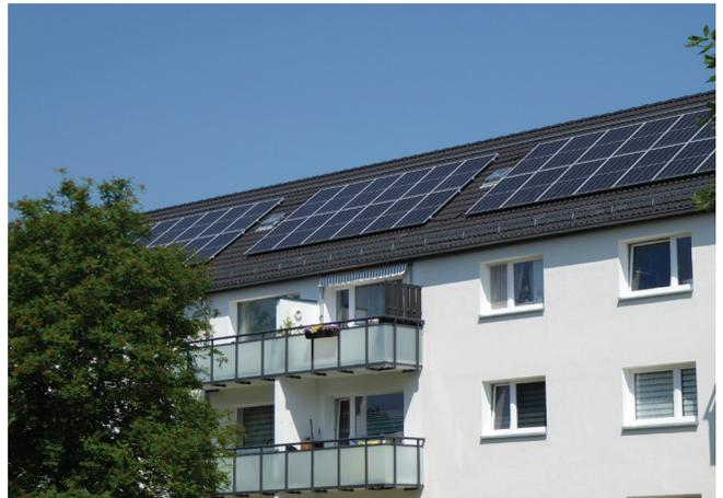
Abb. 118: Photovoltaik-Anlage im Geschosswohnungsbau
