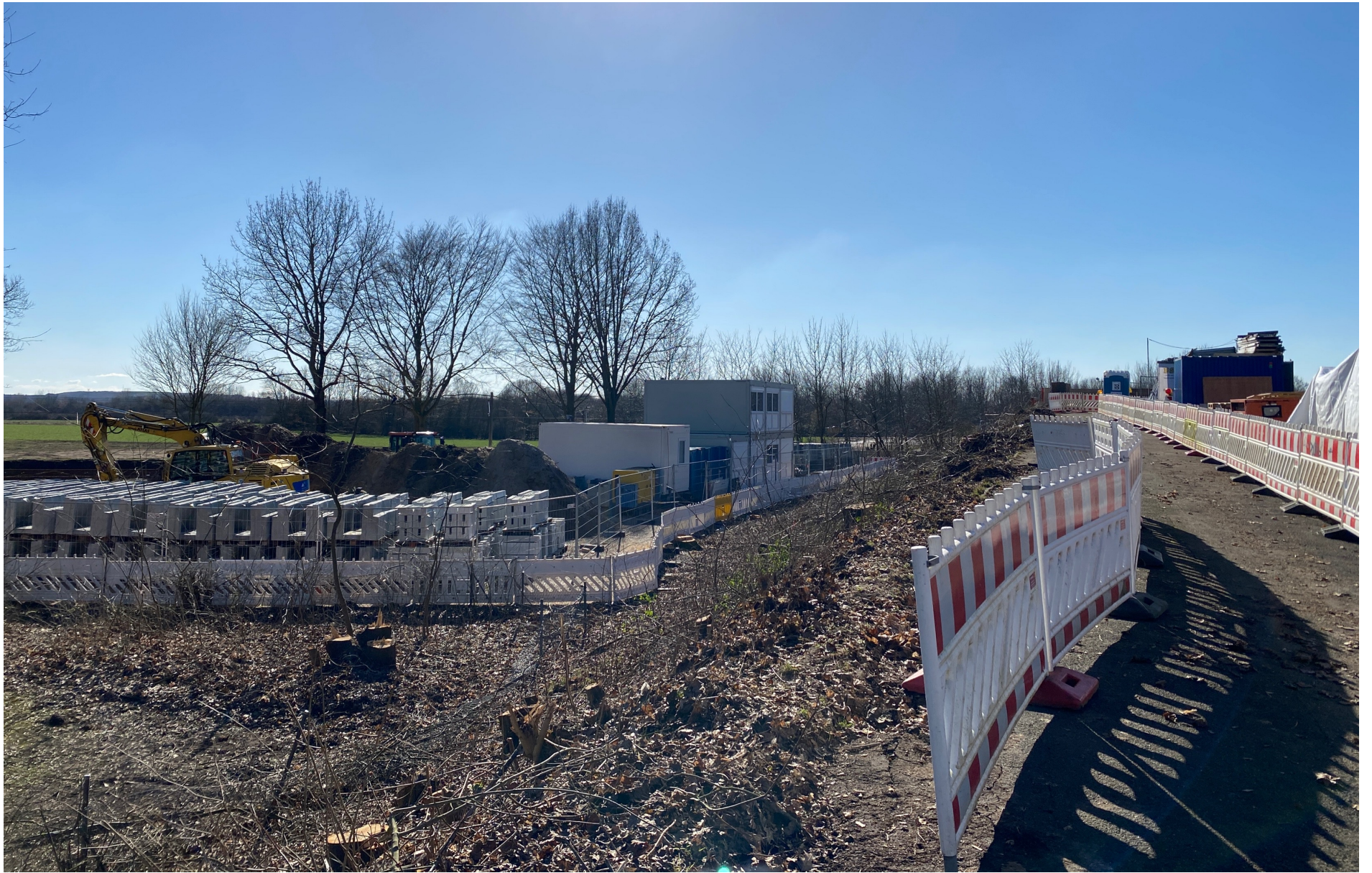
Baufortschritt: neuer Bahnhofsteppunkt
