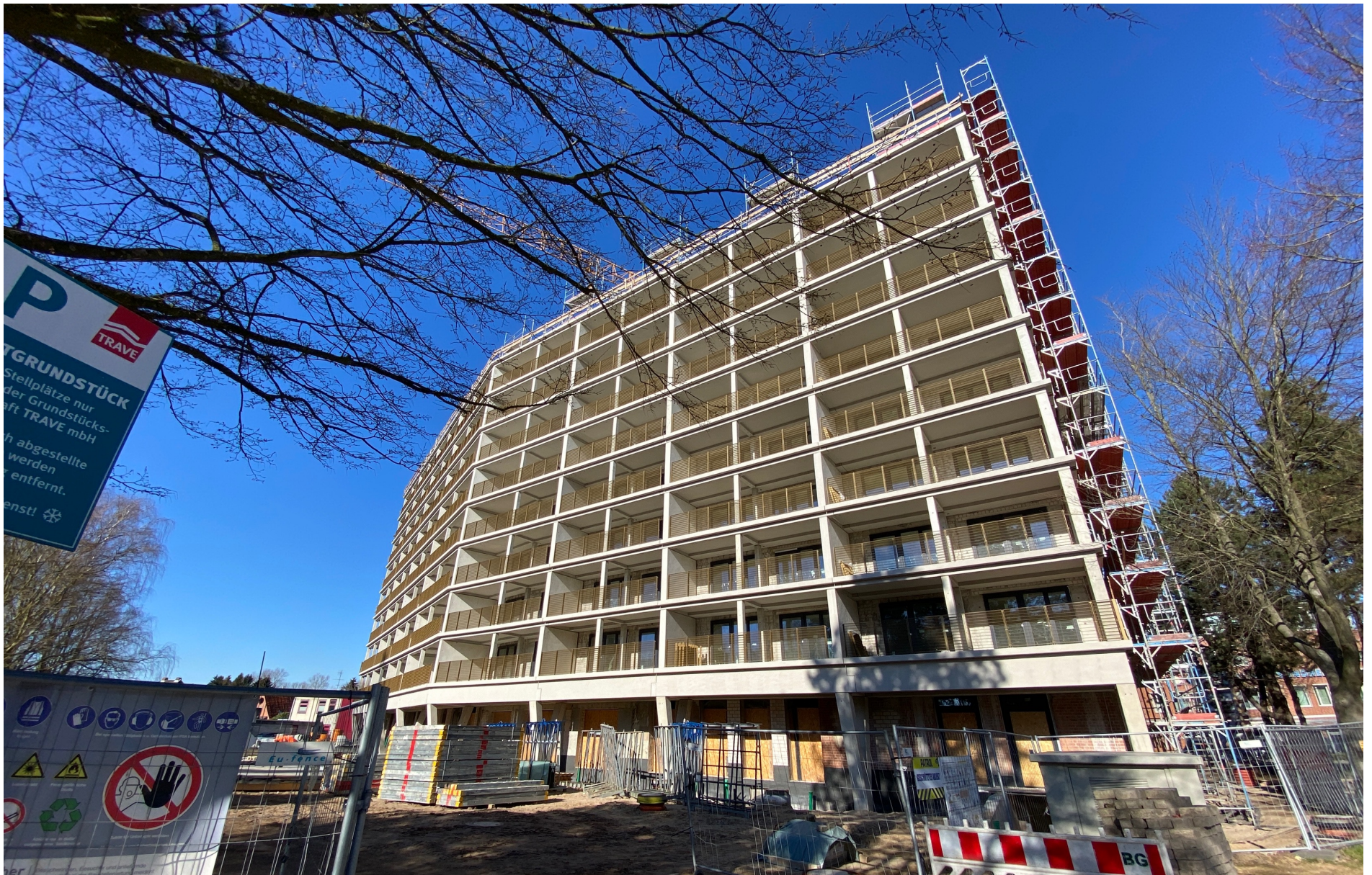
Baufortschritt: Sterntaler Weg
