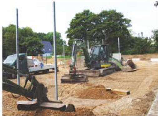
Die Bauarbeiten dauerten von Juni 2019 bis März 2020
