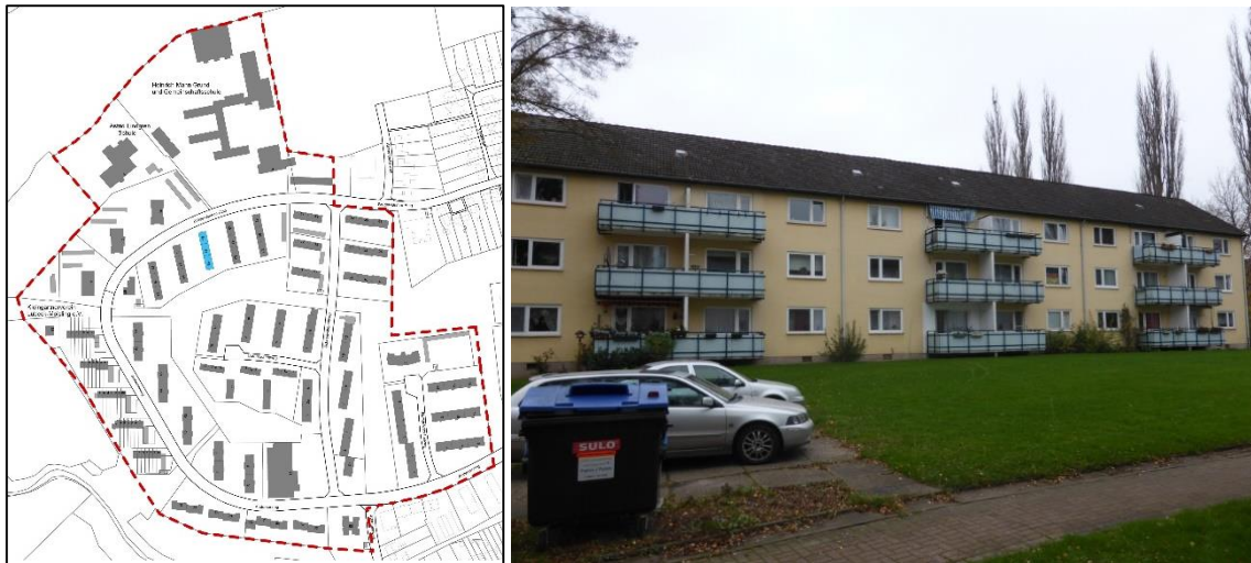
Abbildung 37: Referenzgebäude 2 (räumliche Verortung/ Foto)
