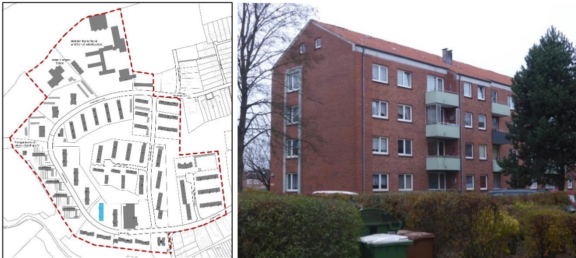
Abbildung 35: Referenzgebäude 1 (räumliche Verortung/ Foto)
