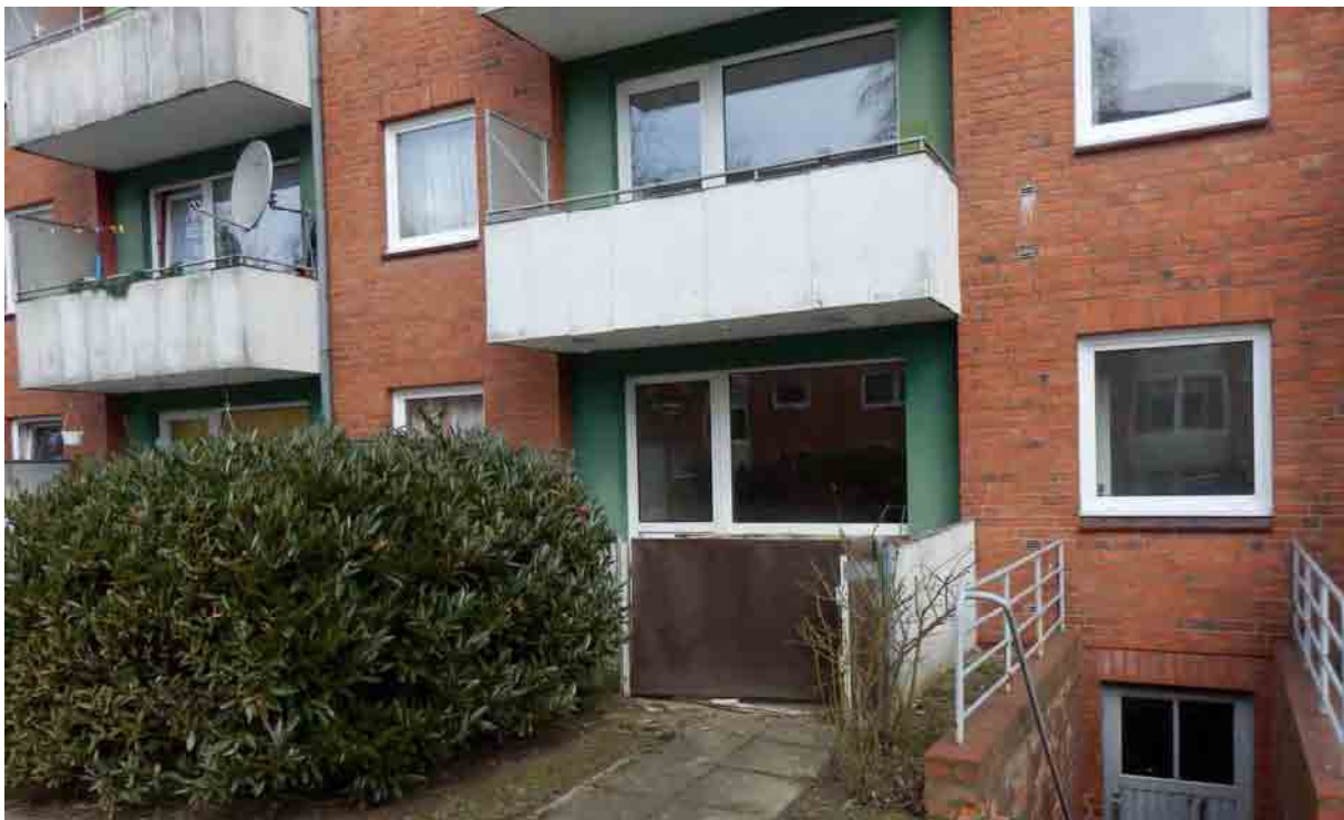
Geschosswohnungsbau mit Modernisierungsbedarf
