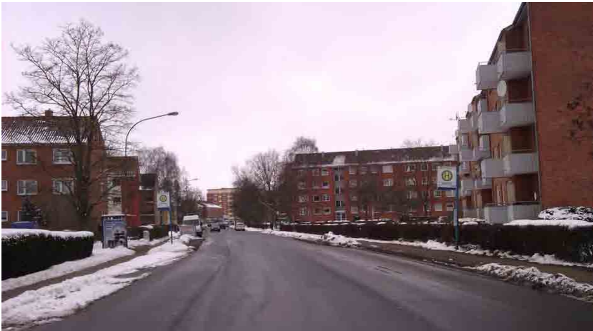
Überdimensionierter Straßenraum (Andersenring)
