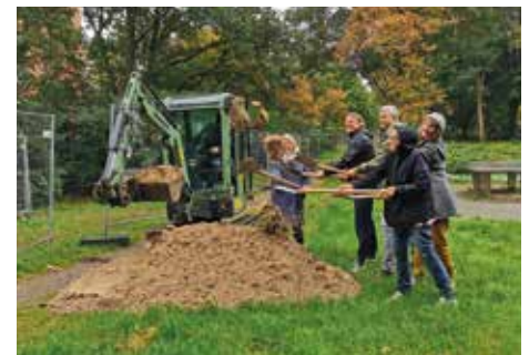
Spatenstich zum Start der Bauarbeiten mit Bürgermeister, Bausenatorin und Stadtteilbeirat, Oktober 2021
