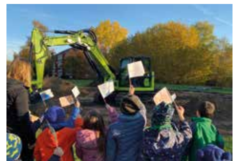
Baggerbegrüßung zum Start der Bauarbeiten mit Kindern der KiTa St. Franziskus, Oktober 2021
