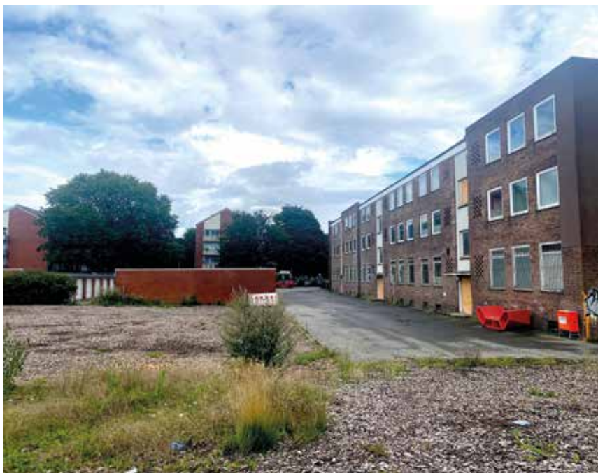
Blick auf die Ladenzeile – hier rollen die Bagger wieder an
