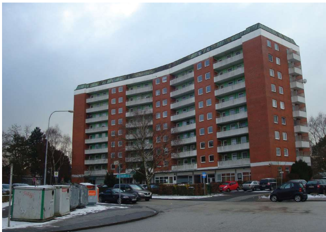
Abb. 6: Sterntalerweg 1-3, Bestand 2020 / vor Sanierung (Quelle: Hansestadt Lübeck)
