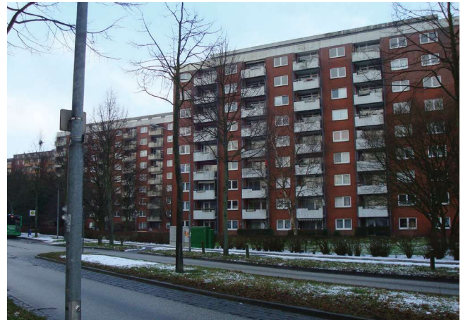
Abb. 10: Scheibenhochhäuser Hasselbreite 1-5, Bestand 2020 / vor Sanierung (Quelle: Hansestadt Lübeck)
